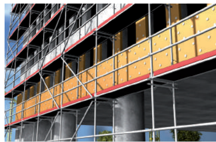
Mocowanie twardych płyt izolacyjnych w fasadach wentylowanych
