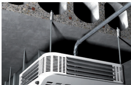
Urządzenia klimatyzacyjne mocowane do płyt kanałowych
