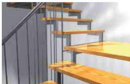
Mocowanie stopnic na schodach metalowych
